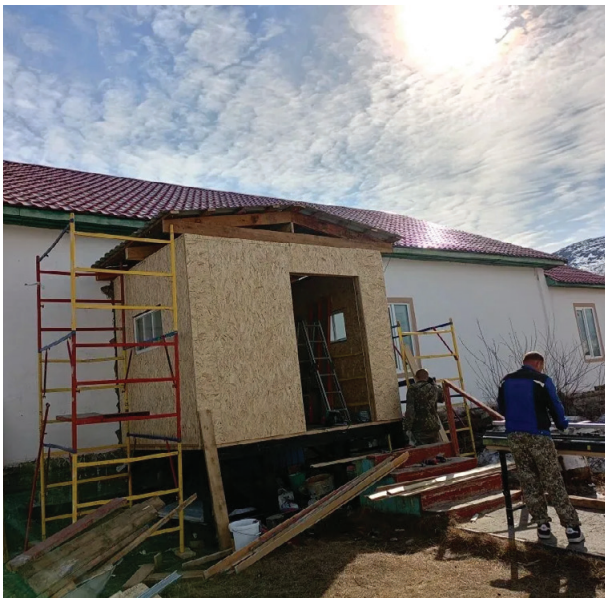
Ремонтные работы в селе Островное
